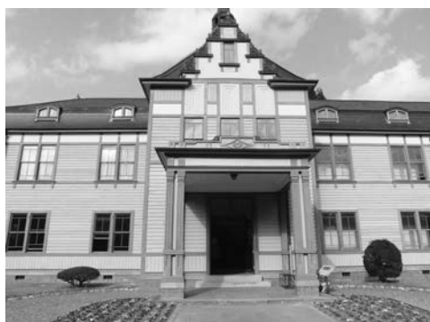
北里研究所本館・医学館外観
